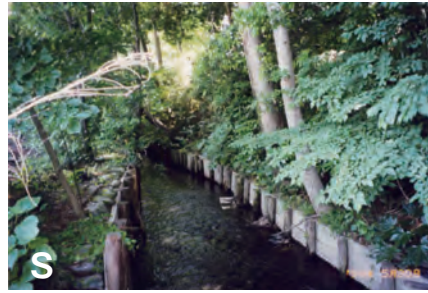
S 2面柵渠の水路が続き
