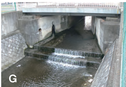
G 落差がある都市雨水幹線との接合部
