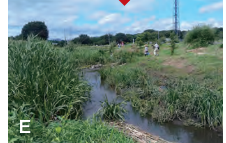
E 2面の柵渠と川底に敷いていたコンクリート板を230m区間撤去して自然護岸を復元した水路
