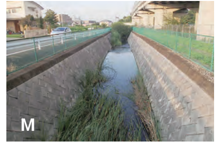
越流水は都市雨水幹線へ流下する
