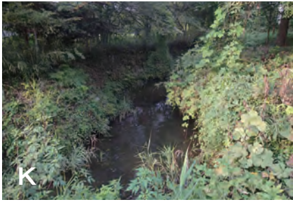
藤中学校校庭脇まで土水路が続く
