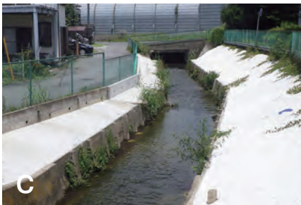
植生が生えないようにした水路
