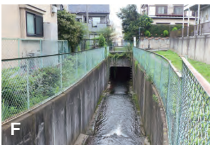
ここから水路は暗渠の中を流れる
