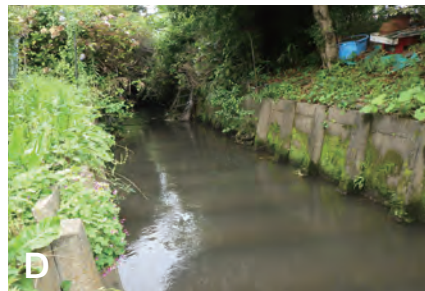
東洋電装まで続く2面柵渠の水路
