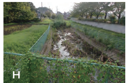
H 関越自動車道を潜る前の南側水路
