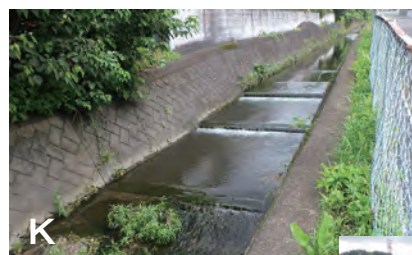
◀東西大谷川の合流点近く。落差工が連続している。
