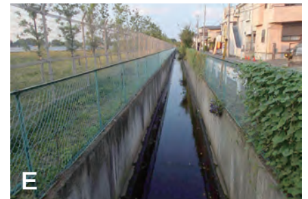
ここから3面護岸の都市雨水幹線に
