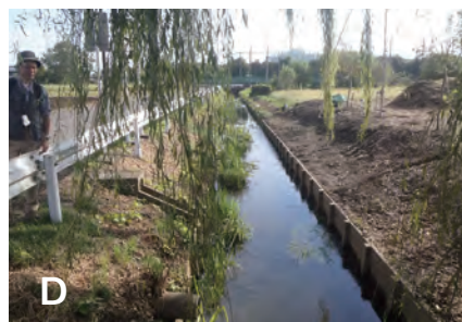
D 柵渠の3面護岸の水路が続く
