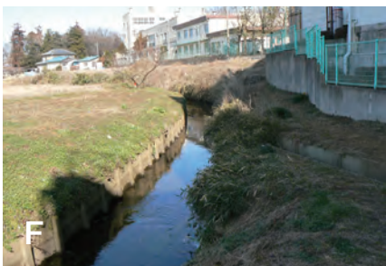
F 再び柵渠の3面護岸の水路が続く
