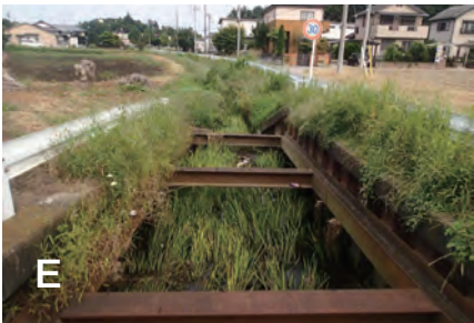
E 護岸を鉄枠で支える2面護岸の水路
