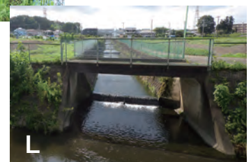
▶合流点下流で流入する富士見工業団地からの排水
