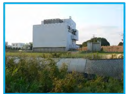
<大谷川のポンプ場>
