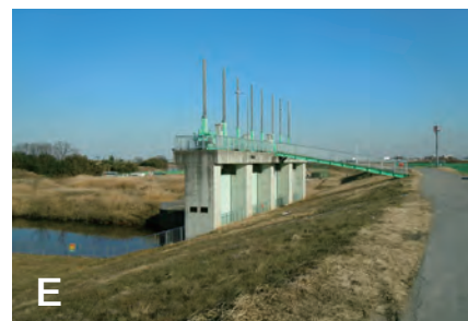
E 越辺川との合流点。樋門の設置に伴いに小畔川から付け替えられた
