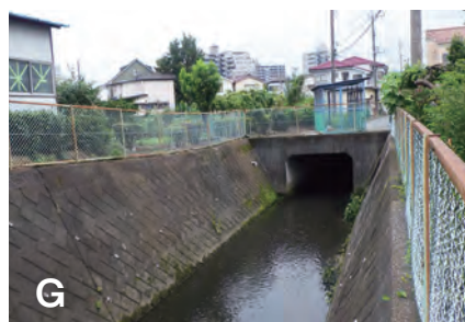
暗渠から開渠の水路に変わる
